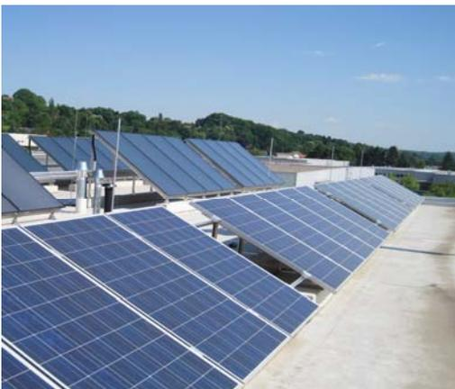
Über die Photovoltaikanlage werden 5.000 kWh/a an elektrischer Energie erzeugt. Diese wird größtenteils zum Ökostromtarif in das öffentliche Stromnetz eingespeist.
