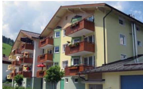
Abb.: Sanierung Reinbachsiedlung, St. Johann
