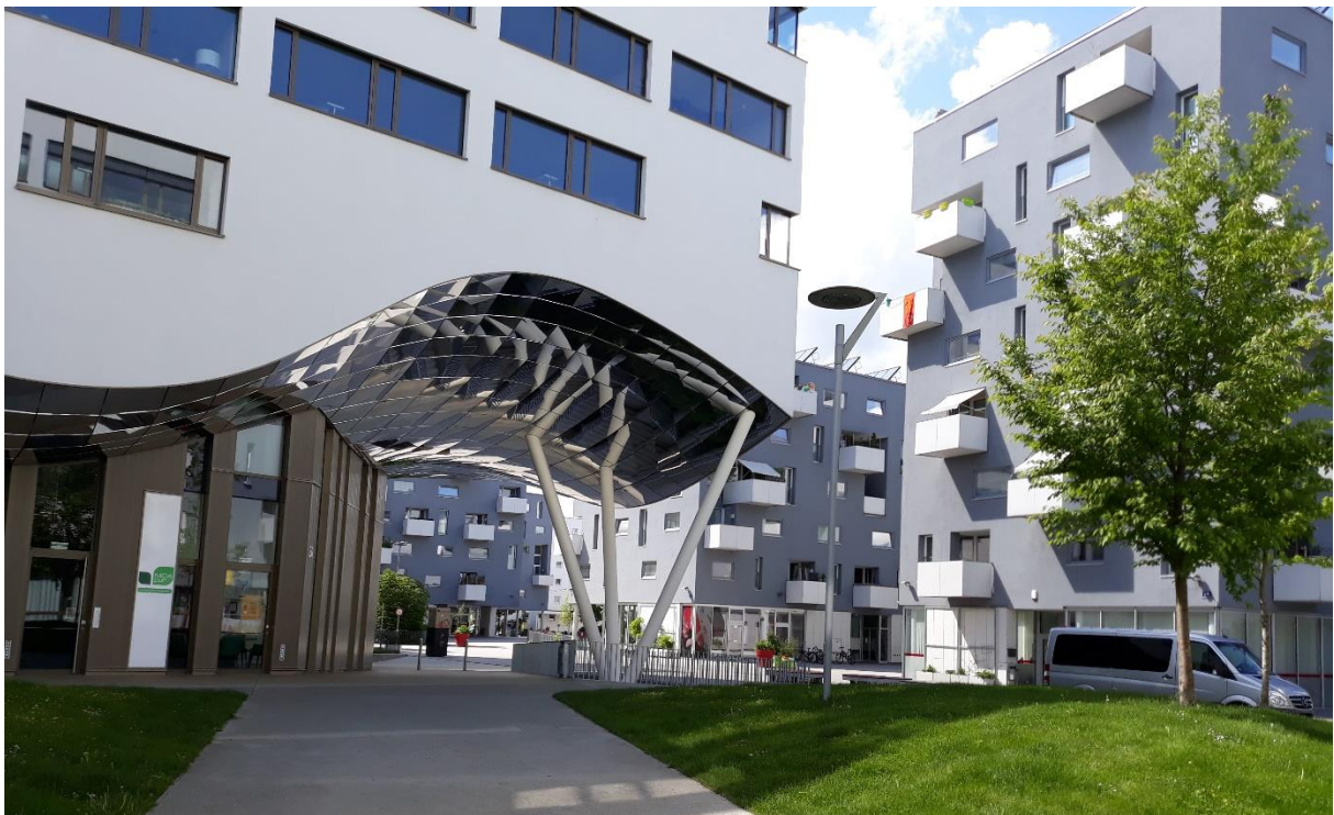
Abbildung 1: Detailansicht im Stadtwerk Lehen
