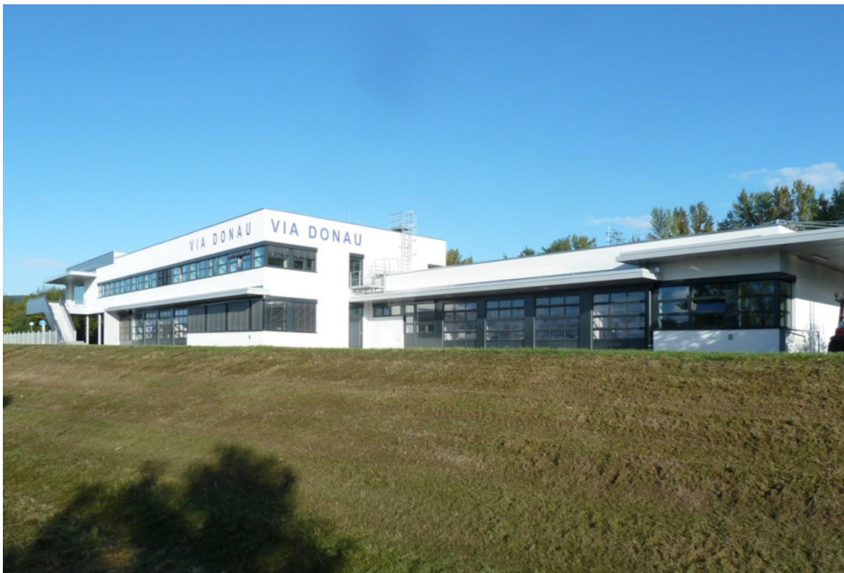
Bild: Servicecenter Wachau/Niederösterreich; Quelle: viadonau – Österreichische Wasserstraßen-GmbH
