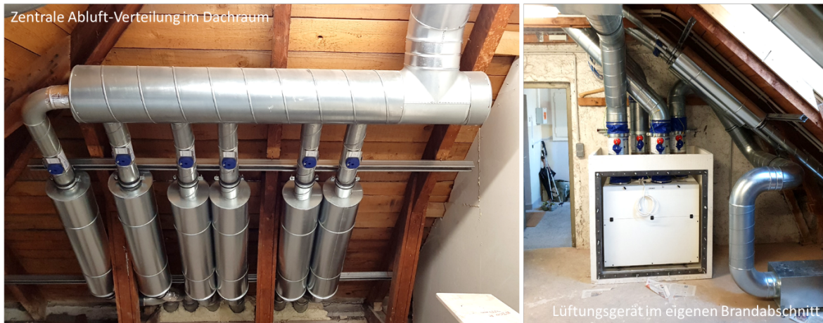
Abbildung 5: Installation der zentralen Lüftungsanlage Pichler LG500 Ventech im Dachgeschoss
