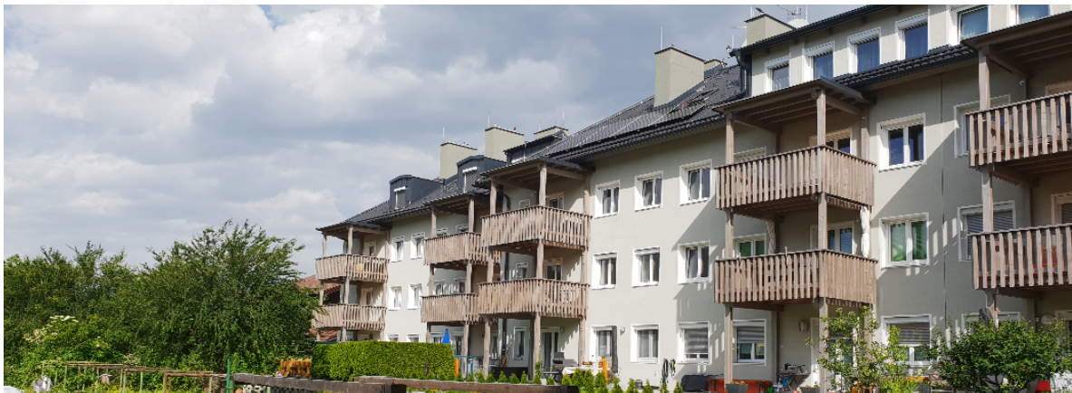
Abbildung 14: : Objekt Lönstraße 20,22,24 Südseite nach der Sanierung
