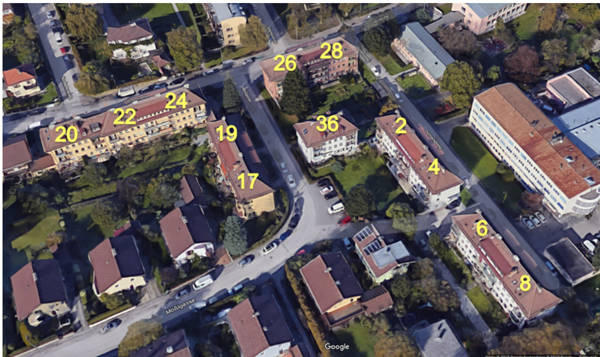
Abbildung 2: Gesamtansicht der unsanierten Objektgruppe
