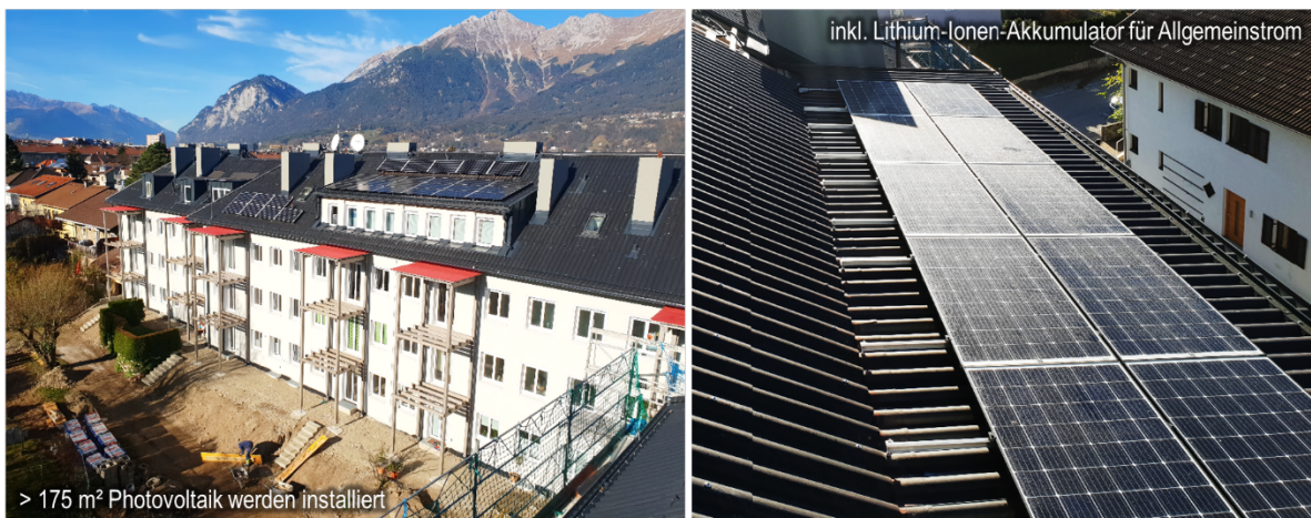
Abbildung 11: Montage der PV-Anlage
