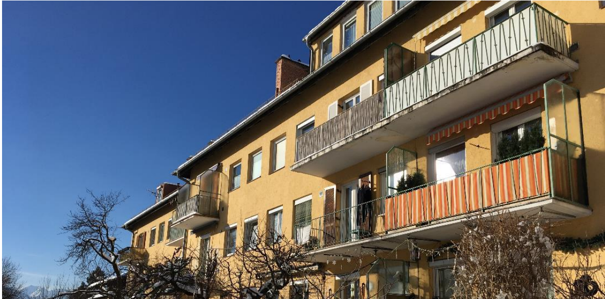
Abbildung 13: Objekt Lönstraße 20,22,24 Südseite vor der Sanierung
