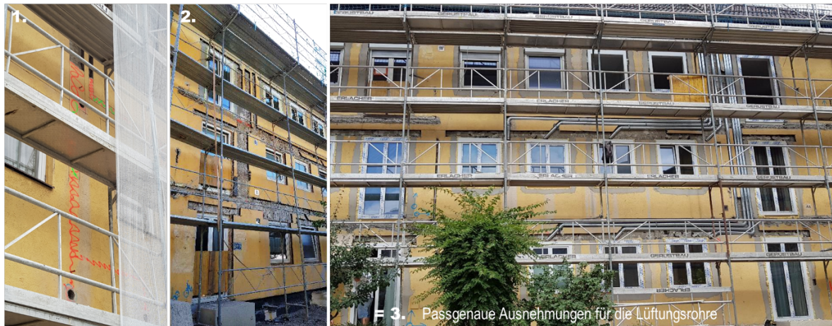
Abbildung 8: die 3 Schritte zur passgenauen Montage der Lüftungsrohre in der Dämmebene
