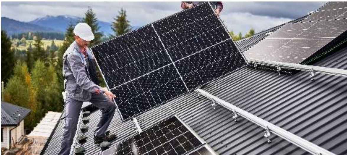
Installation von PV-Modulen (Bild: stock.adobe.com – anatoliy_gleb)
