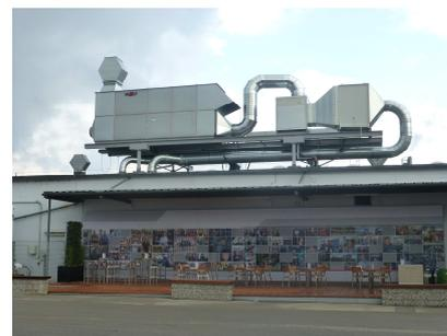
Durch den Einbau einer Wärmerückgewinnung errechnet sich eine **Energieeinsparung** unter Berücksichtigung der Betriebszeiten und der durch die Heizung aufzubringenden Energie von **554.500 kWh/a**. Das entspricht einem Gasverbrauch von 55.450 m<sup>3</sup>/a bzw. einer jährlichen CO<sub>2</sub>-Einsparung von 124.538 kg.
