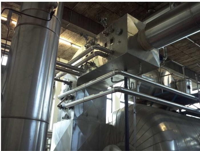
Die Energie aus dem Economizer wird für die Speisewasservorwärmung, Frischwasservorwärmung des gegenständlichen Sattdampfkessels und die Frischwasservorwärmung eines Reindampferzeugers verwendet.
