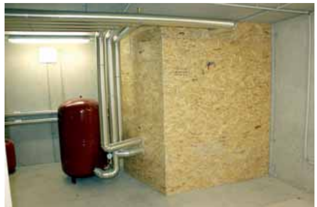
▲ Schüttdämmungen bieten in Verbindung mit Trockenbauverschlüssen eine kostengünstige und energieeffiziente Alternative.
