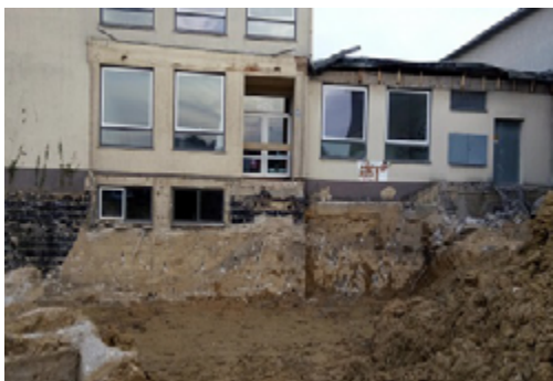
Während der Sanierung
