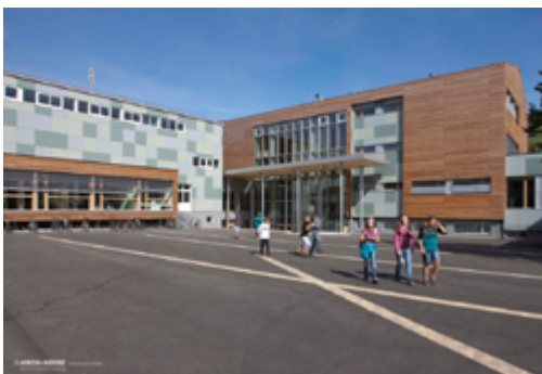
NMS Neumarkt nach der Sanierung
