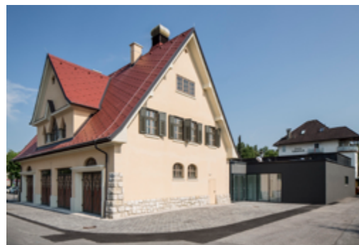
Passivhaus und Erhaltung der historischen Fassade
