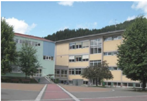
NMS Neumarkt vor der Sanierung
