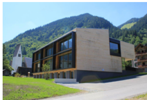
Außenansicht des Schulbaues in Passivhausqualität
