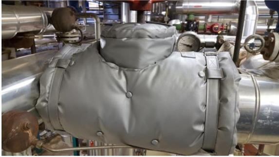
© Fresenius Kabi Austria, Flexible Isolierung einer Dampfleitungsarmatur
