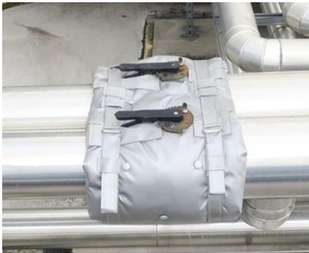
© Fresenius Kabi Austria, Flexible Isolierung einer Heizungsleitungsarmatur
