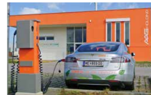
Die AAG Holding GmbH setzt auf Elektromobilität. Mit der Ladestation der Janker Immobilien GmbH ist das Elektrofahrzeug immer bestens versorgt.
