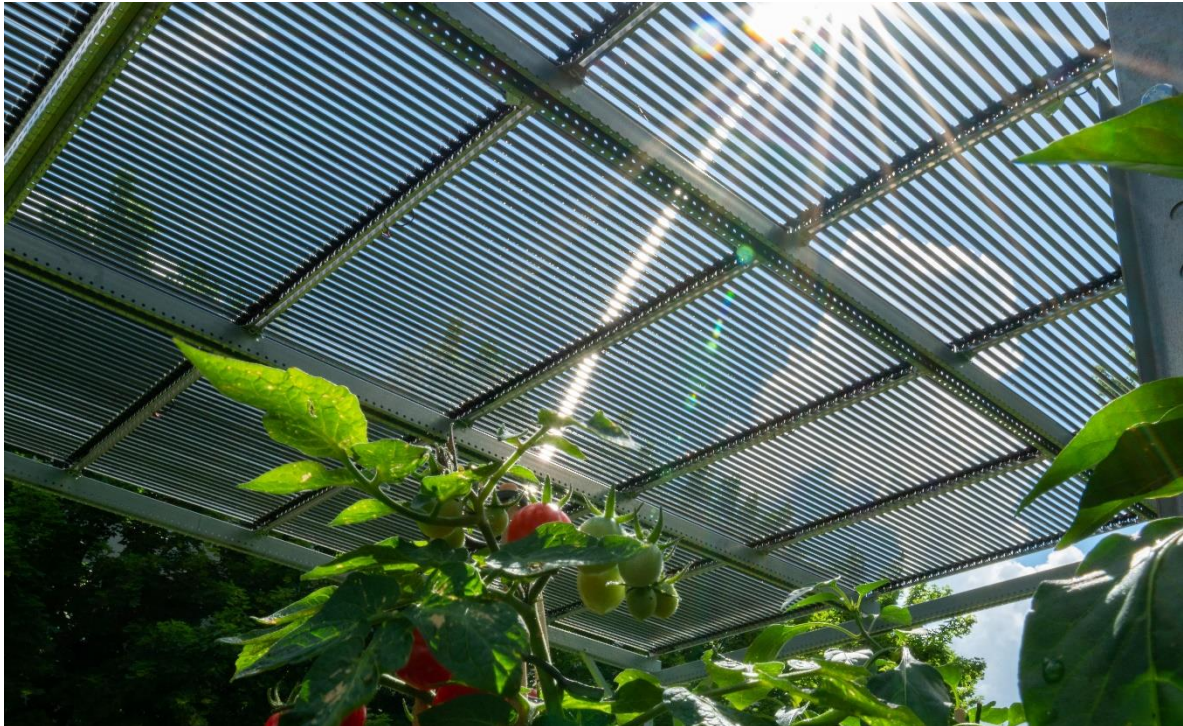
Abbildung 8: Agri-PV System mit schlauchförmigen Dünnschichtmodulen in Kombination mit Tomaten
