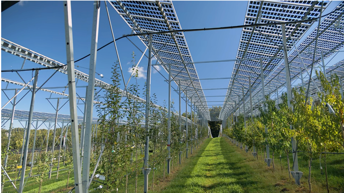
Abbildung 18: Aufgeständerte Agri-PV-Anlage in Haidegg in Kombination mit einer jungen Apfelplantage
