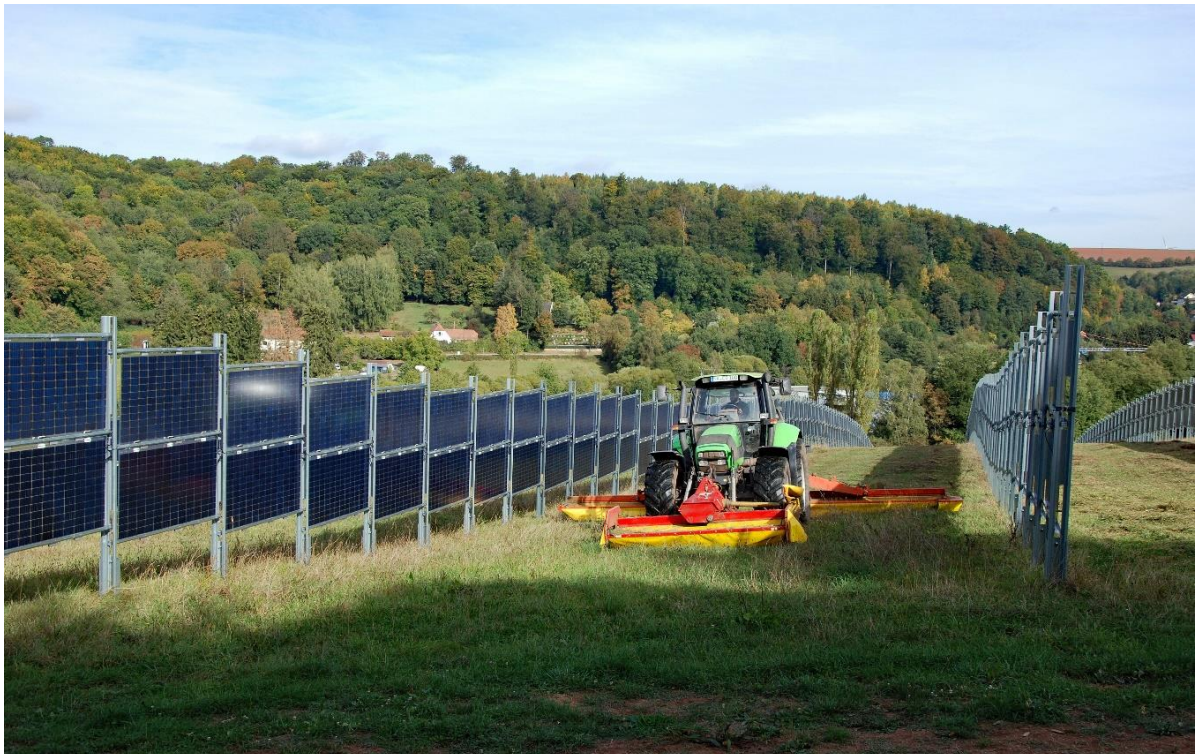
Abbildung 9: Vertikale APV-Anlage mit bifazialen Modulen
