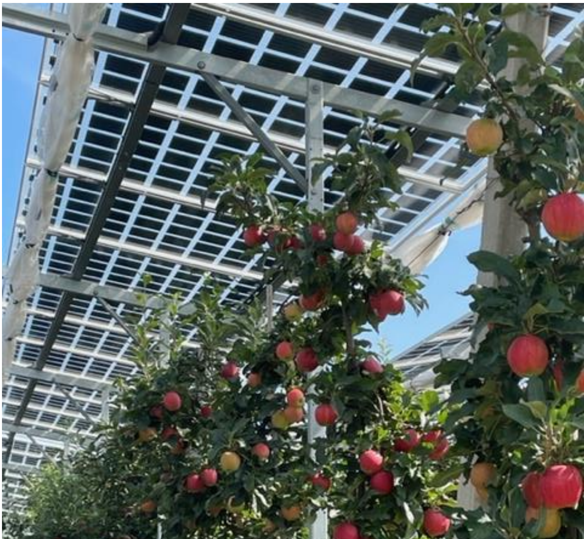
Abbildung 4: Agri-PV Anlage im Obstbau
