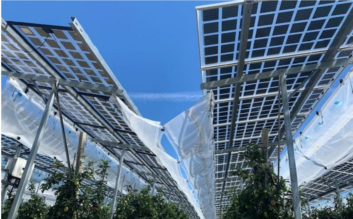
Abbildung 6: Agri-PV-Anlage in Kressbronn mit zusätzlichen Hagelnetzen
