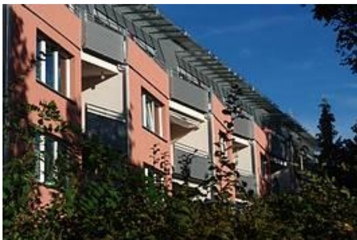
Abbildung 1: Nachverdichtung im Rahmen der energetischen Sanierung: Dachaufstockung am Projekt Bernadottestrasse, Nürnberg; Arch. B. Schulze-Darup
