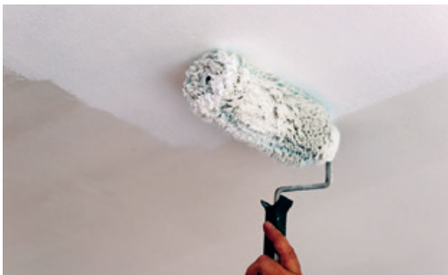
Auftrag einer Dispersionsfarbe mit der Farbrolle
