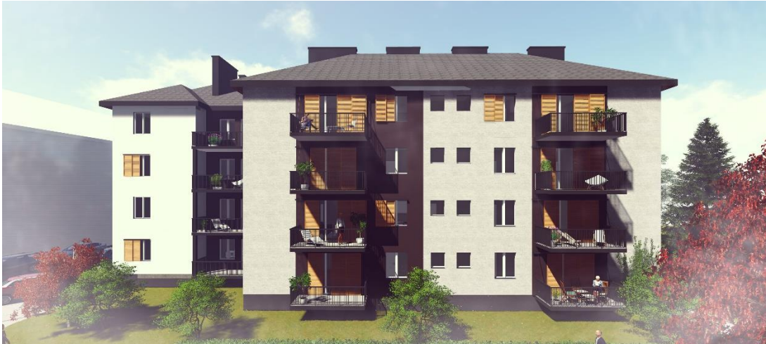
Abbildung 2: Hovengasse 24, Korneuburg/Niederösterreich, nach Sanierung
